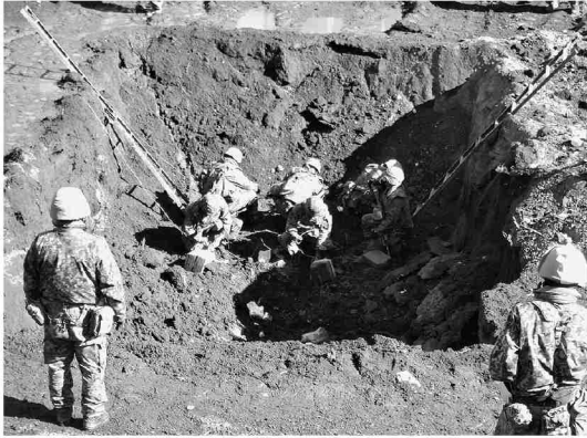
爆破訓練（壕処理）
