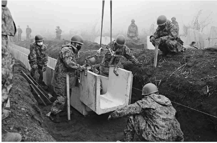
排水設備の工事(第1普通科連隊)
