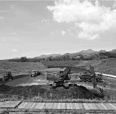
基本射場のフラット化工事を実施する第12施設隊
