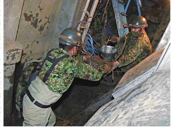
浄水場取水口の土砂を除去する第34普通科連隊の隊員
