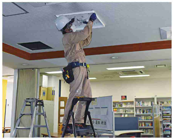
厚生センターの内装工事を行う隊員(新町駐屯地)
