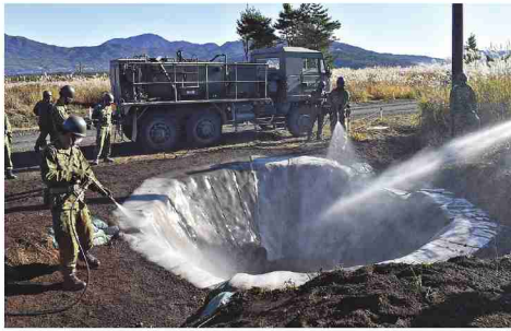
コンクリートキャンバスによる溜枧硬化のための放水(北富士演習場)
