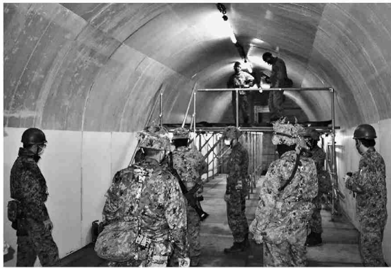
指揮所用掩蓋壕の構築(第5施設群)
