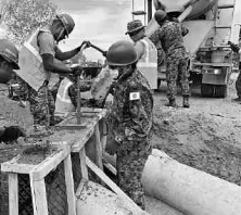
コンクリート打設を指導する隊員
