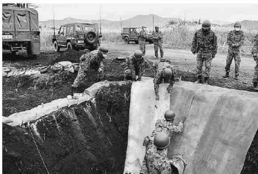
コンクリートキャンパスによる溜槽を整備する32普連
