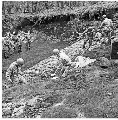
平塚道崩落箇所の整備
