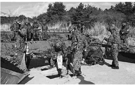
滑走路の被害復旧
