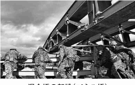
混合橋の架設(パネル橋)
