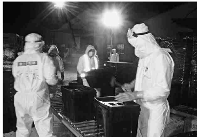
夜間作業の状況(八千代町)
