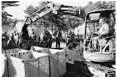
ソイルアーマー（左下）を活用した陣地構築
