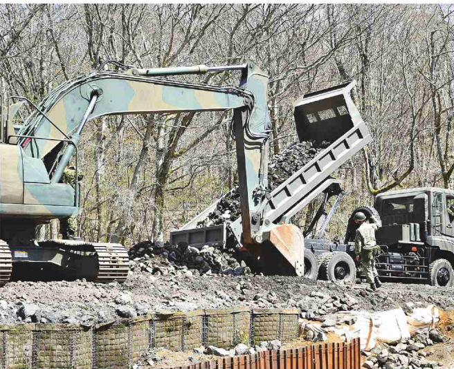
崩落箇所を整備する第306施設隊
