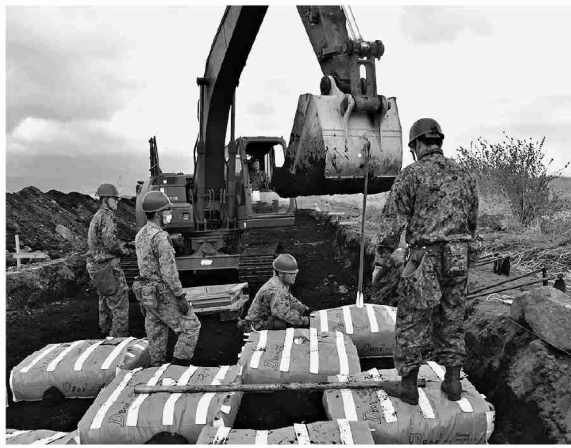
戦車道の改修 D-Box設置
