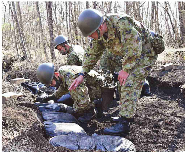
側溝を整備する第4施設群
