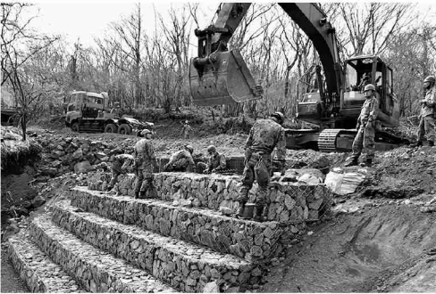
崩壊部の補修のための布団籠設置
