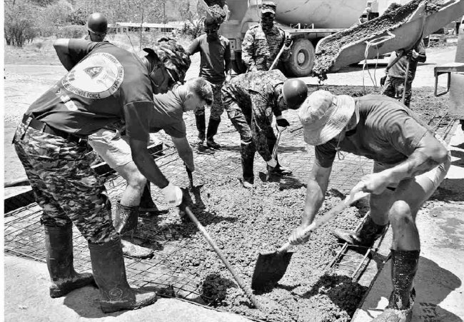
メティナ口基地内での鉄筋コンクリート道路構築
