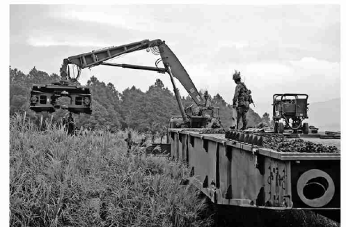
07式機動支援橋架設(1施大)
