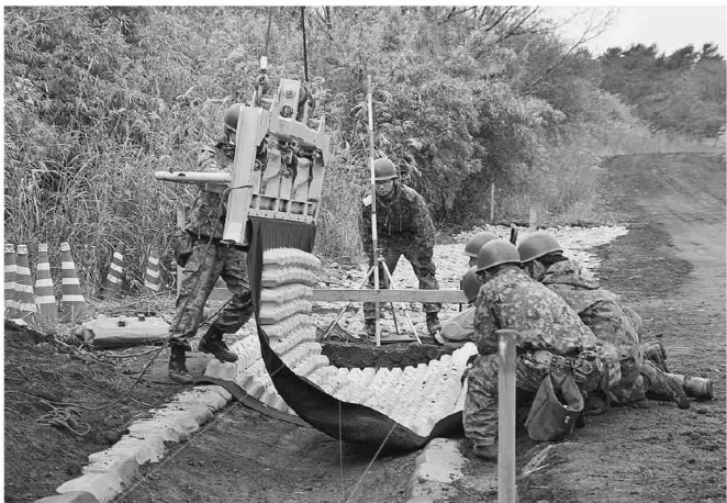
排水設備の改修 ブロックマットの設置
