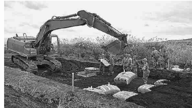
戦車道の改修 D-Boxの設置
