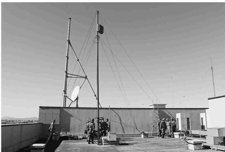
勝田駐屯地屋上の開設状況
