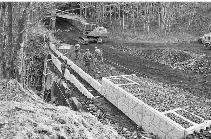
機動路の改修 箱型よう壁
