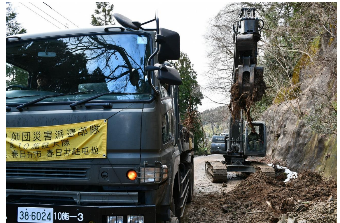
輪島市門前町にて土砂崩れに伴う道路啓開
