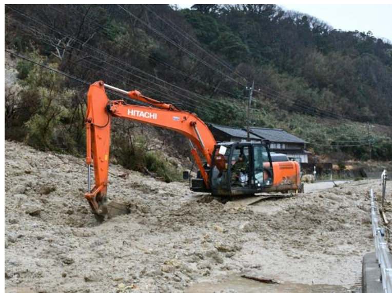
新たな土砂崩れにおける道路啓開（珠洲市塩田村）
