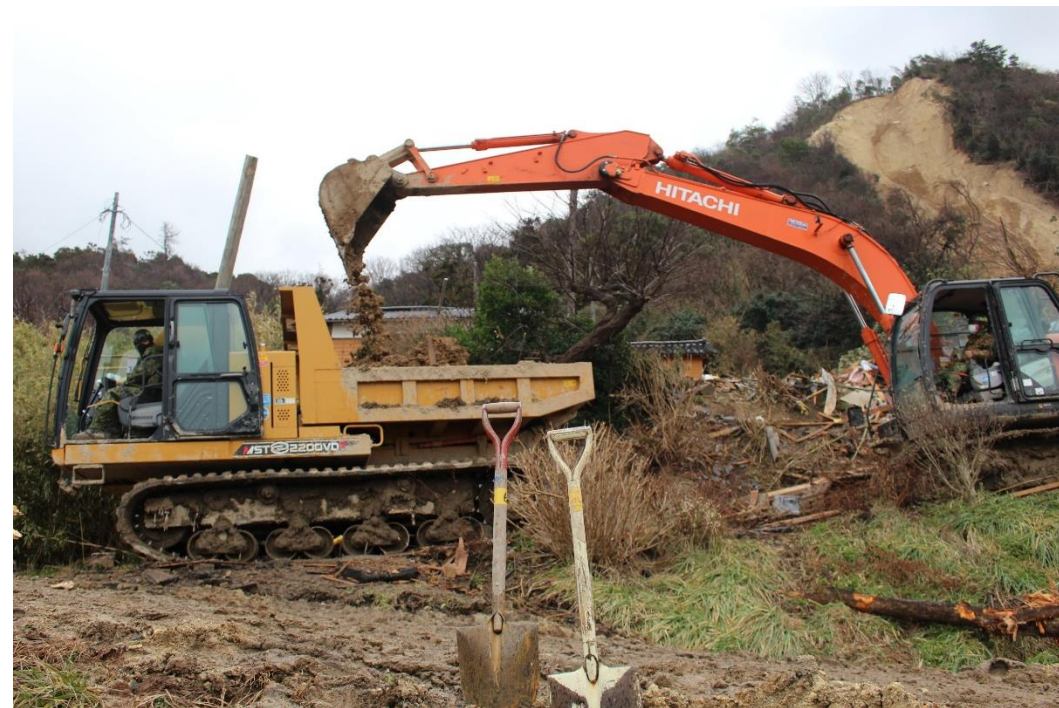
行方不明者捜索のための土砂の除去（珠洲市塩田村）
