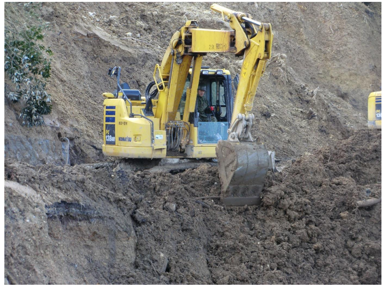
珠洲市仁江町塩田村 消防、警察と連携した土砂崩れに係る行方不明者の捜索に伴う土砂及び瓦礫の撤去（第10施設大隊）
