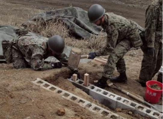
戦車指揮台の階段構築(305施設隊)
