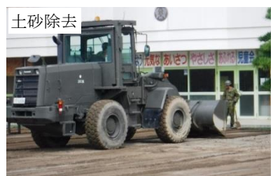
土砂除去 第7施設群(栃木市)
