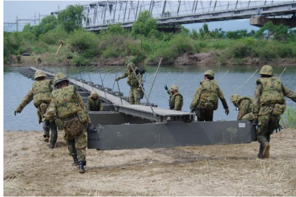
機能別訓練（徒橋の架設）
