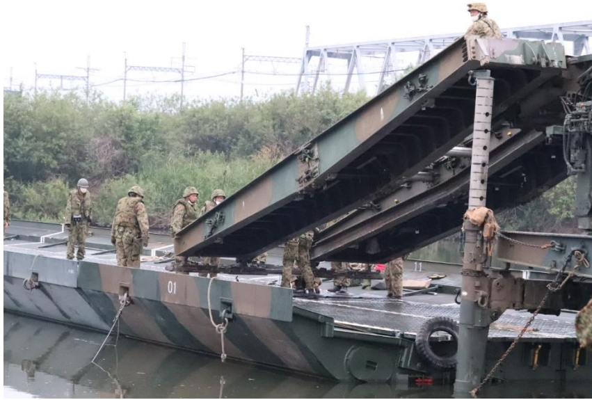
総合訓練（混合橋の架設）
