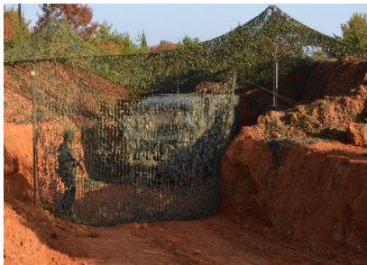
通信所掩壕構築（中部方面通信群）
