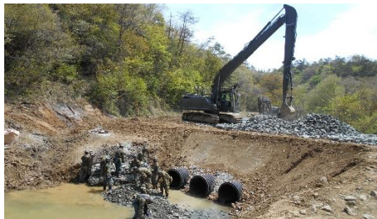
上古賀南道暗渠の新設（あいば野）
