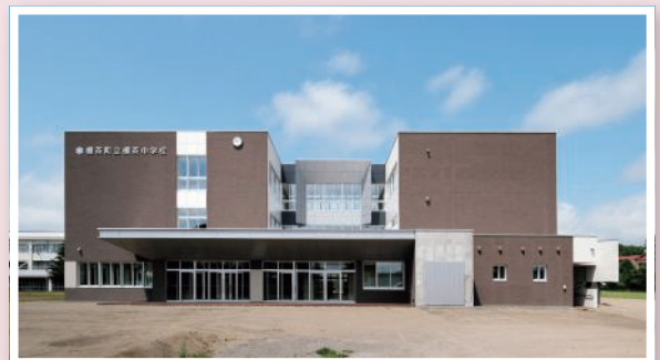
騒音防止工事の助成（北海道川上郡標茶町標茶中学校）
