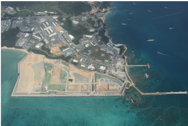
2023年4月 埋立工事の進捗状況
