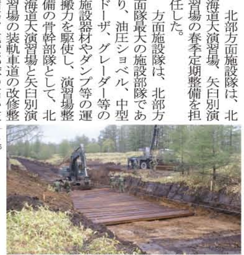
装軌車道荒廃箇所整備 (矢臼別演習場)
