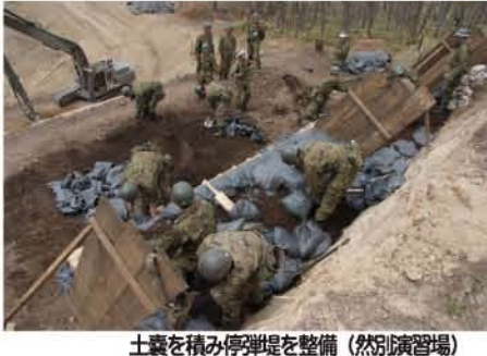
土壌を積み弾薬庫を整備 (然別演習場)
