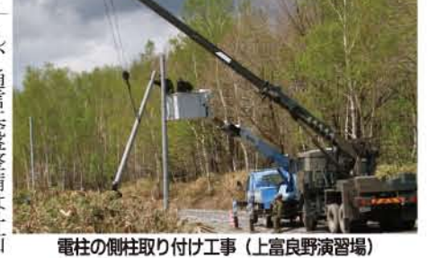
電柱の側柱取り付け工事 (上富良野演習場)
