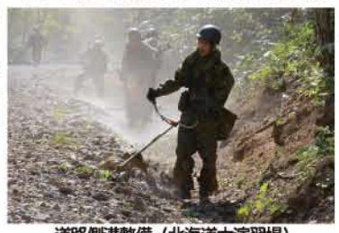
道路側溝整備 (北海道大演習場)
