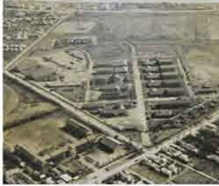
現在の函館駐屯地
