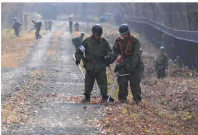
東千歳地区における道路整備（北海道大演習場）
