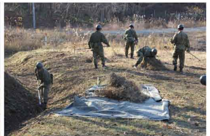
H-0地区における道路整備（北海道大演習場）
