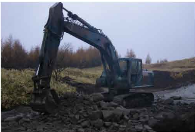
装軌車道整備（矢白別演習場）
