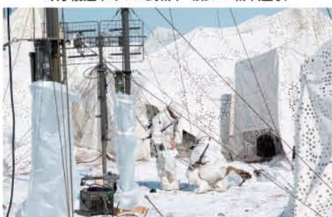
指揮所内におけるアンテナの設置 (第7通信大隊)
