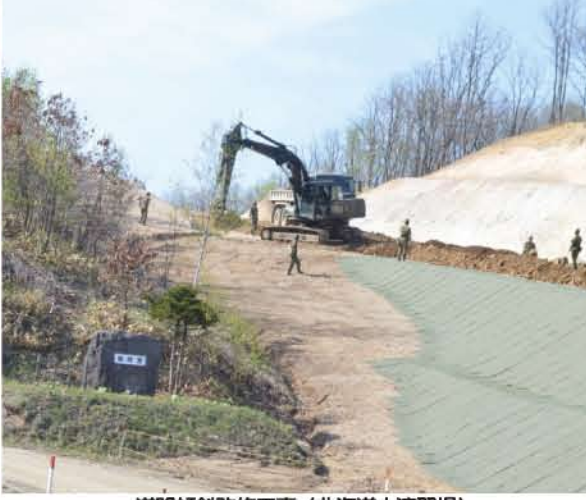
道路傾斜改修工事 (北海道大演習場)
