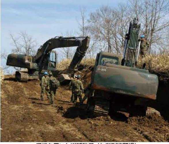
重機を用いた道路整備 (矢白別演習場)
