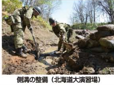
側溝の整備 (北海道大演習場)
