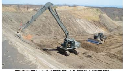
重機を用いた射場整備 (北海道大演習場)
