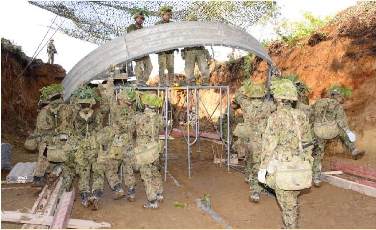
防衛演習における旅団指揮所掩壕の構築
