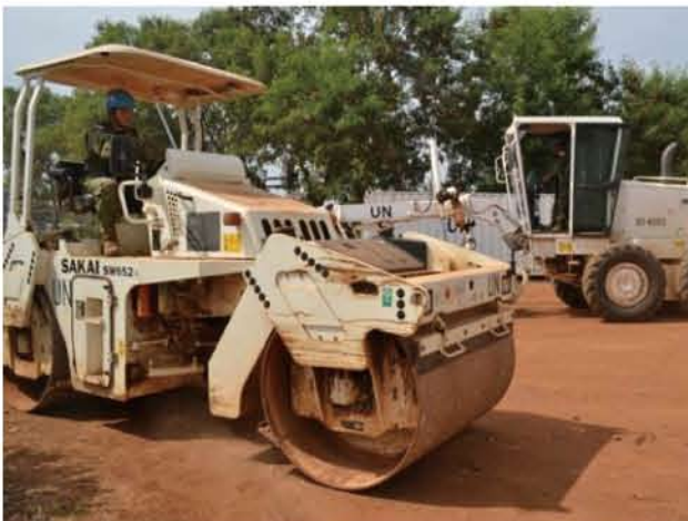
現地における施設隊の活動(道路整備)
