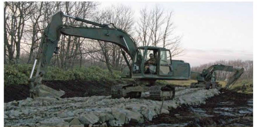
大型重機による装軌車道整備
