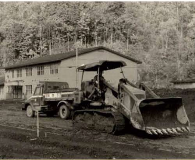
日高分屯地起工
