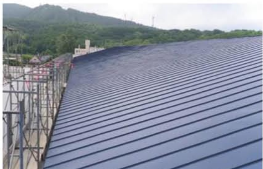
完成した屋根（施工後）
