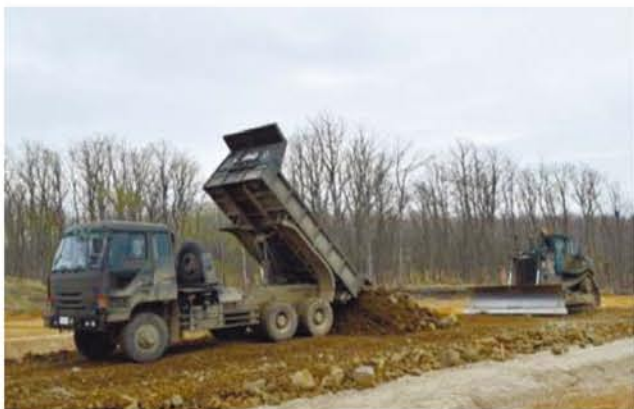
装軌車機動路の新設（北大演）
