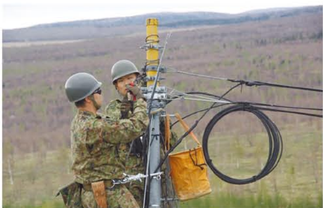
光ケーブルの新設（上富良野）
