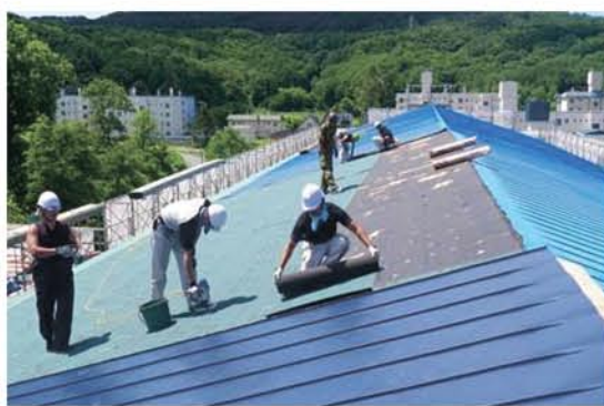
木工係による屋根の補修（施工中）
