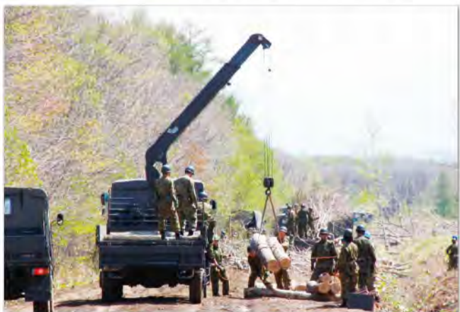
装軌車道の拡幅 (伐採) (北海道大演習場)
