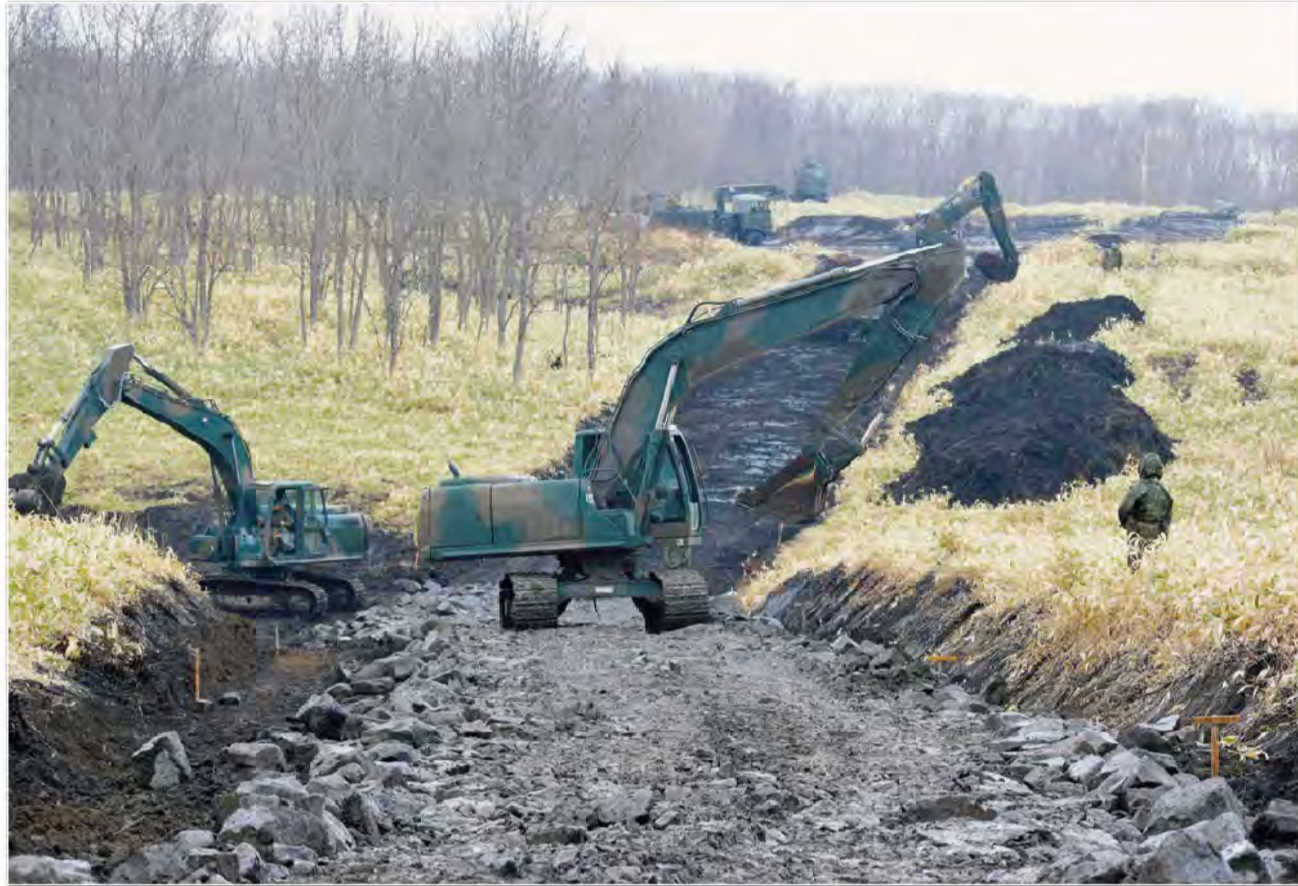
装軌車道新設整備 (矢白別演習場)
