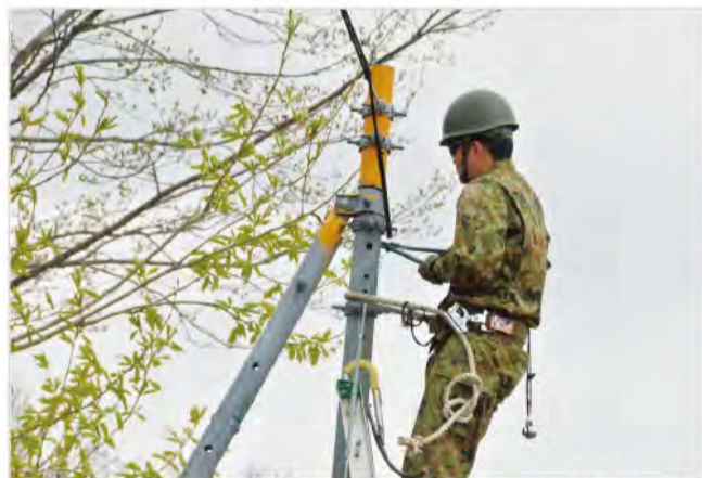
光ケーブルの構成 (上富良野演習場)
