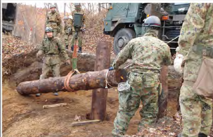
道路崩落箇所の土留め構築
