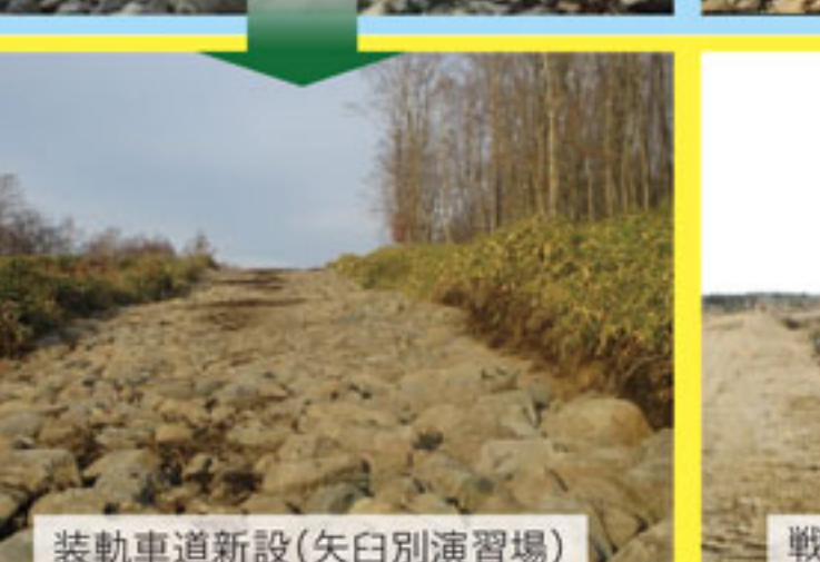
装軌車道新設(矢白別演習場)
