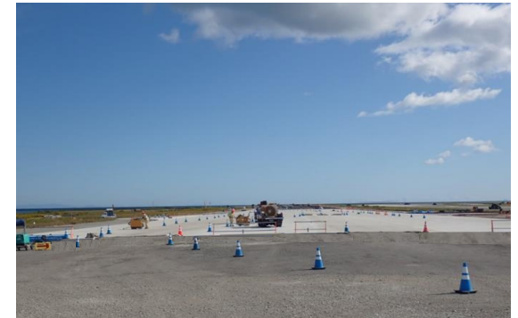
緊急時の使用のための施設整備 (現状)
