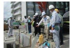
防衛施設の建設工事（監督業務）を行う事務官等（イメージ）
