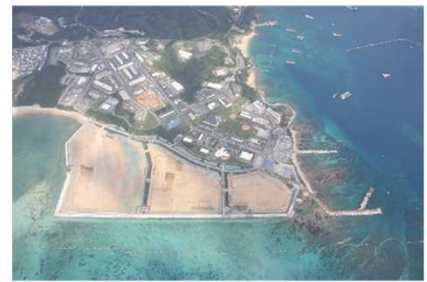
普天間飛行場代替施設の建設 (現状)
