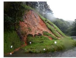
法面の崩落
