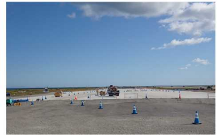
緊急時の使用のための施設整備 (現状)
