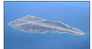
馬毛島における施設整備
