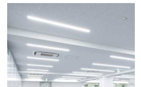
LED照明器具へ更新
