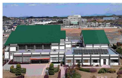
公共用施設の一部(体育館)
