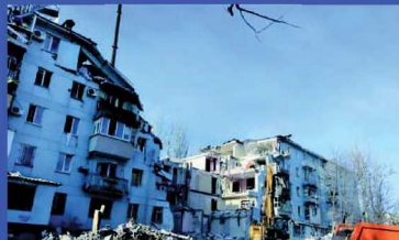
露軍のミサイル攻撃により破壊されたザポロジージャ市の集合住宅(2023年3月) 【ウクライナ緊急事態庁】
